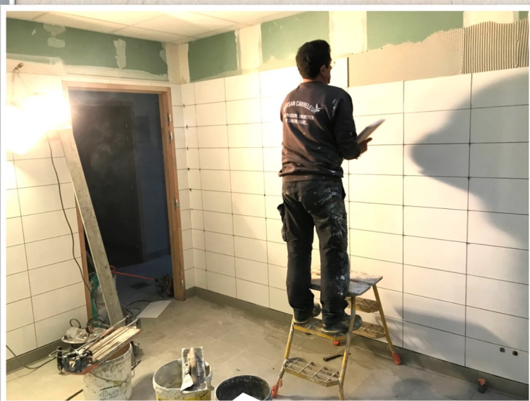
Aménagement de la cuisine
